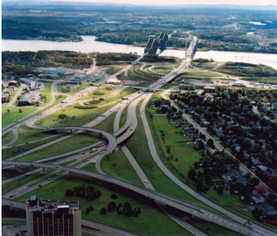
Figure 1 : photographie aérienne, ponts et échangeurs
