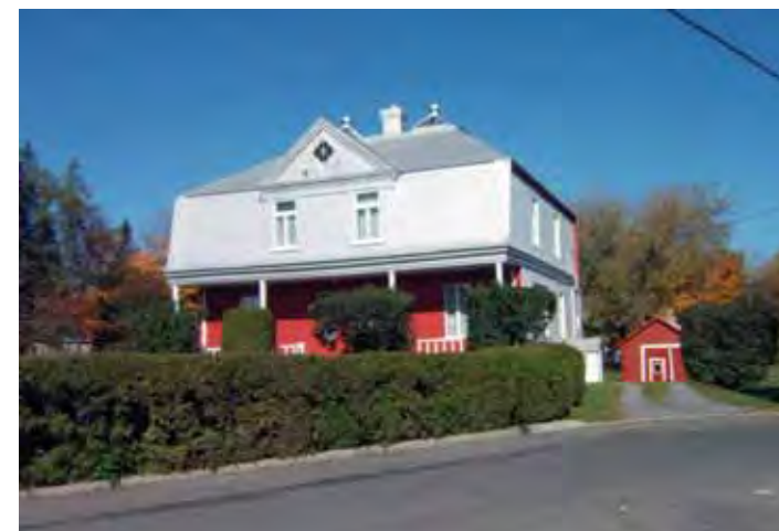
FIGURE 49 Importance visuelle de la couverture La forme et le matériau de revêtement du toit définissent le caractère architectural du bâtiment (7694, avenue Thomas-Baillairgé)
