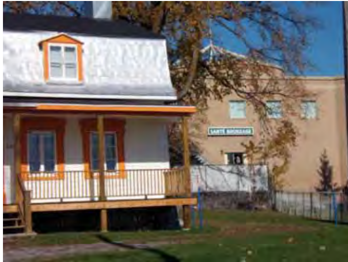
FIGURE 15 Constructions visibles du Trait-Carré Est Bâtiment commercial sur le boulevard Henri-Bourassa, surplombant le bourg
