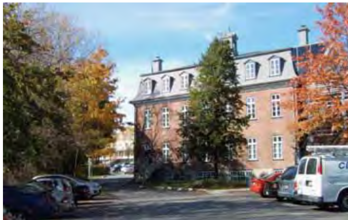
FIGURE 46 L'ancien collège Saint-Charles
