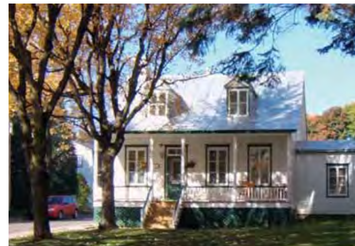
FIGURE 50 Distribution traditionnelle des ouvertures Maison du chapelain, couvent du Bon-Pasteur (733, boulevard Louis-XIV)
