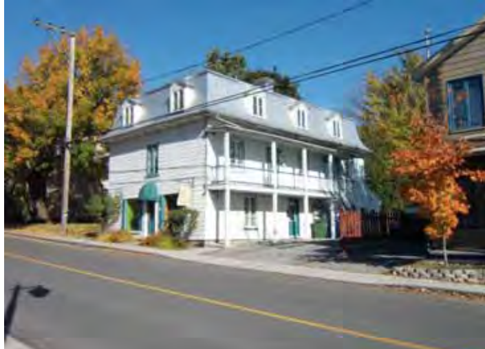
FIGURE 25 Un bâtiment à usage mixte traditionnel 7890-7912, 1 re avenue
