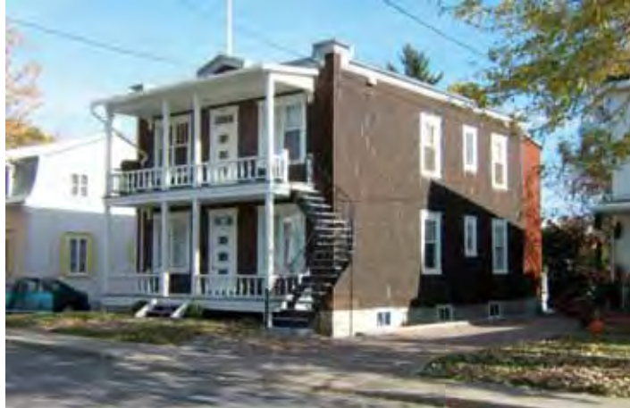
FIGURE 37 Maison à toit plat 688-690, boulevard Louis-XIV
