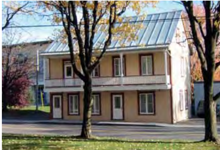
FIGURE 48 Emploi traditionnel des couleurs Distinction entre les surfaces planes, les éléments ornementaux et les huisseries des fenêtres (734-736, boulevard Louis-XIV)
