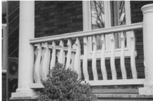
La courbure des barrotins donne à ce garde-corps toute son élégance. Leur remplacement par des barrotins droits constituerait une grande perte pour ce bâtiment.
