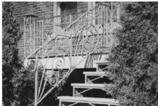
La courbure des barrotins donne à ce garde-corps toute son élégance. Leur remplacement par des barrotins droits constituerait une grande perte pour ce bâtiment.
