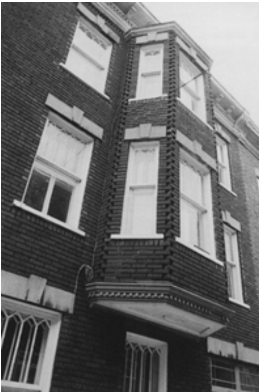
95. Les oriels des quartiers centraux de Québec sont pour la plupart revêtus de bois, mais on en trouve aussi quelques exemples en maçonnerie.
