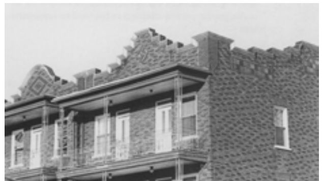
36. Corniche de couronnement en métal, caractérisant les façades postiches des maisons de type boom town.
