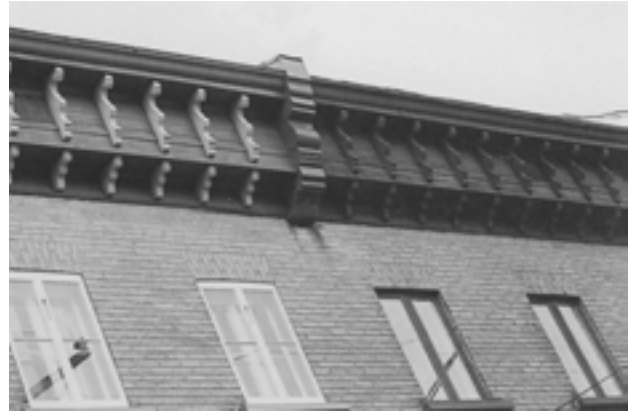
34. Corniche à double soffite avec modillons et consoles en bois.
