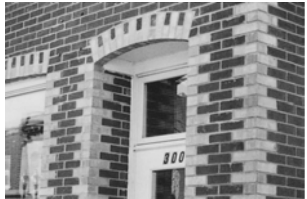
48. Jeux de briques contrastantes marquant les coins et les ouvertures, quartier Saint-Roch.
