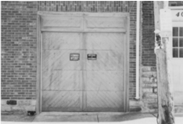
70. Porte de remplacement acceptable, en bois, à ouverture horizontale, de fabrication traditionnelle.
