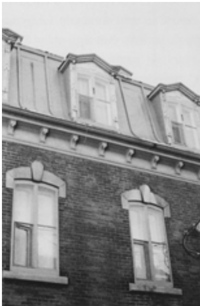
49. Insertion d'éléments de pierre formant les linteaux et les appuis des fenêtres.
