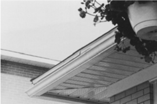
37. Avant-toit des maisons de type bungalow avec soffite d'aluminium perforé pour la ventilation du toit.
