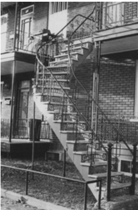
90. Les escaliers en fer ornemental sont typiques du quartier du Vieux-Limoilou. Différents détails et motifs agrémentent les rampes et les contremarches.
