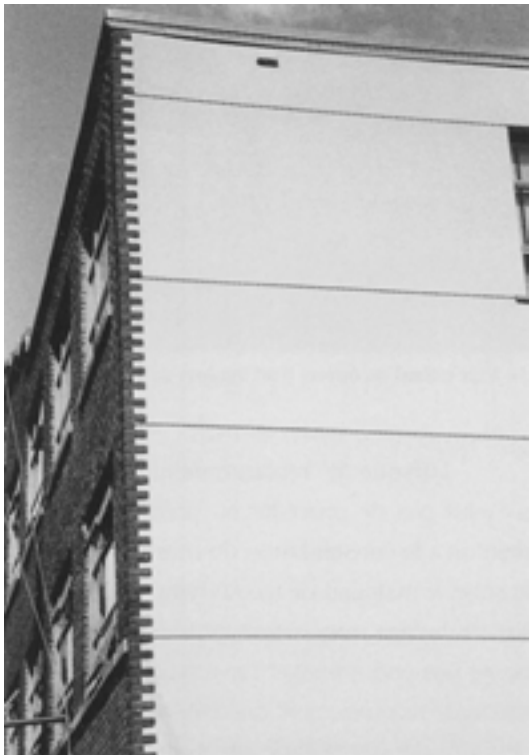
53. Mur latéral bordant un lot à construire et recouvert d'un enduit . Le passage d'un matériau à l'autre est souligné par le chaînage d'angle.
