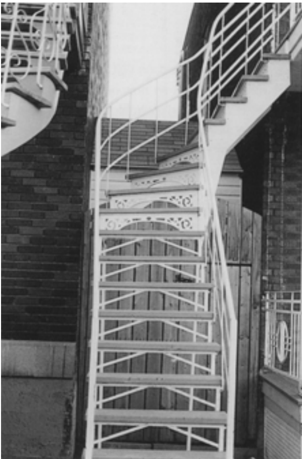
83. Les contremarches constituent ici le principal élément décoratif. On peut facilement les réintégrer dans la construction d'un nouvel escalier.
