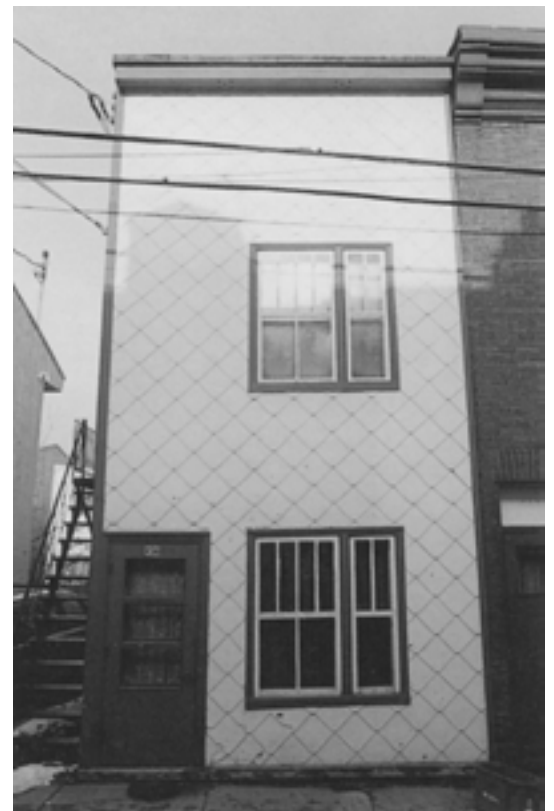
43. Revêtement léger à motif d'écailles de poisson, sur l'annexe d'un bâtiment de Saint-Jean-Baptiste.
