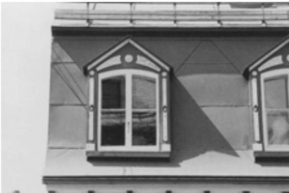
27. Couverture de tôle en feuille.
