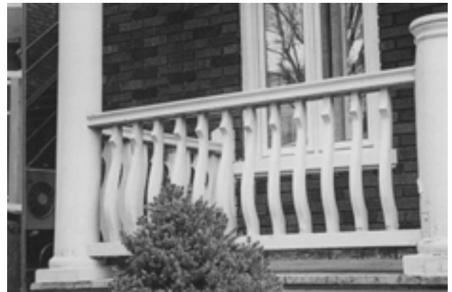
84. La courbure des barrotins donne à ce garde-corps toute son élégance. Leur remplacement par des barrotins droits constituerait une grande perte pour ce bâtiment.
