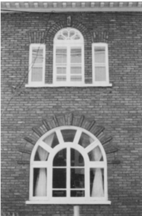
74. Ces fenêtres de conception unique forment un ensemble et ne pourraient être remplacées que par des fenêtres ayant exactement les mêmes divisions.
