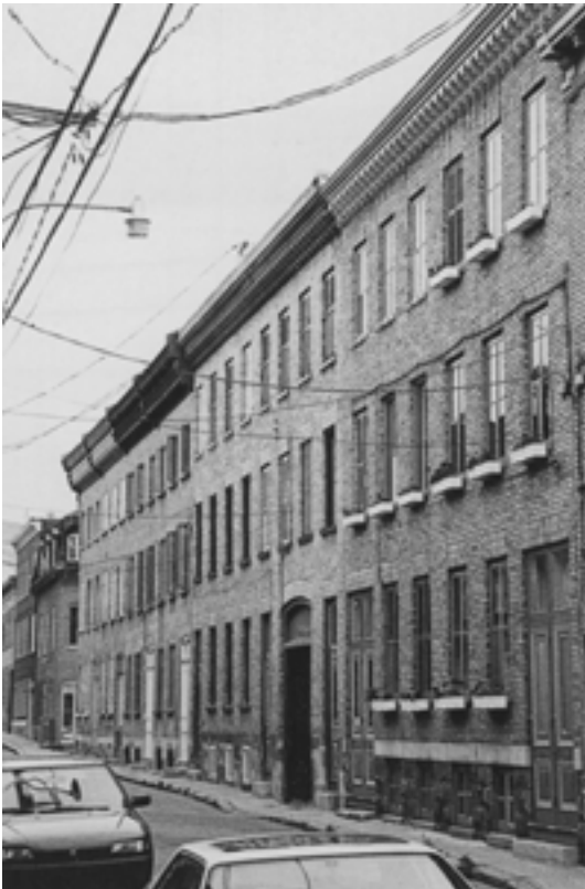
44. Ensemble d'immeubles en massif de maçonnerie, dans le quartier Saint-Jean-Baptiste. Ce mode de construction donne des ouvertures étroites et alignées.
