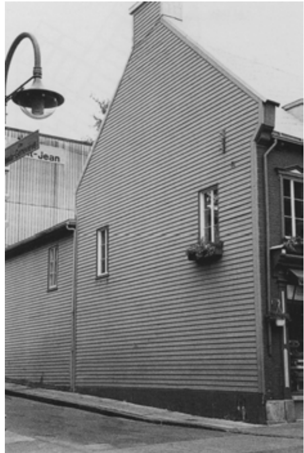
51. Mur latéral recouvert d'un lambris de bois.
