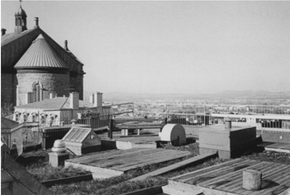
716. Aménagement paysager sur la toiture d'un édifice du quartier Saint-Jean-Baptiste. Promenades, terrasses et plantations de fines herbes participent à la qualité de vie des occupants et des occupantes.
