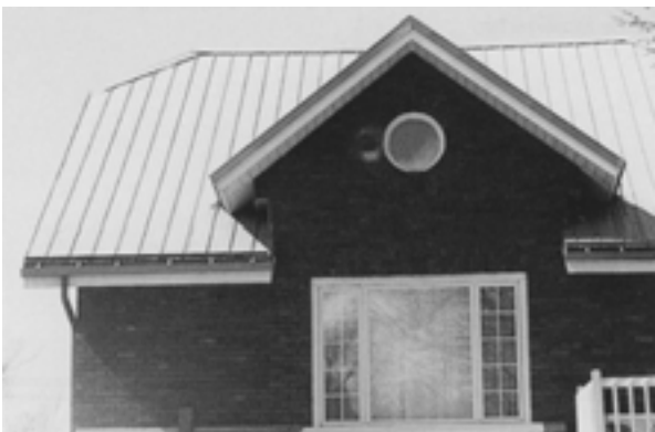
28. La tôle d'imitation profilée est un matériau de substitution acceptable.
