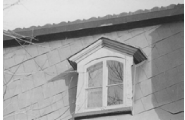
24. Couverture en tôle à la canadienne.
