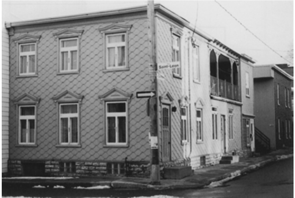
56. Bâtiment du quartier Saint-Sauveur recouvert d'amiante à motif d'écailles de poisson.
