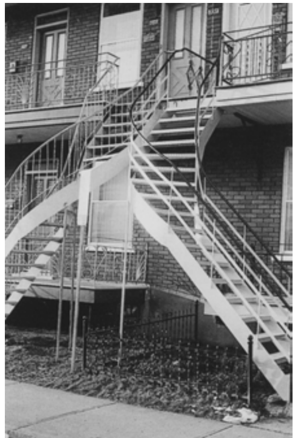
81. Le remplacement par un escalier à limons pleins est malheureux, les limons ajourés formant une dentelle beaucoup plus agréable à l'oeil.
