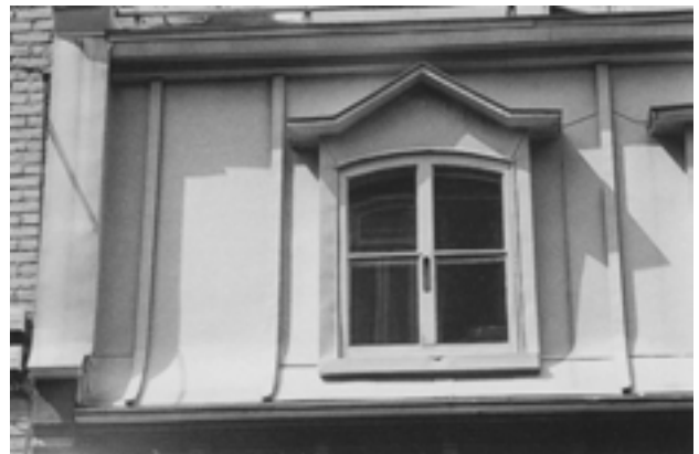
25. Couverture en tôle à baguettes.
